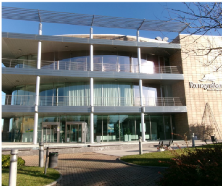
La sede di Sala di RomagnaBanca
